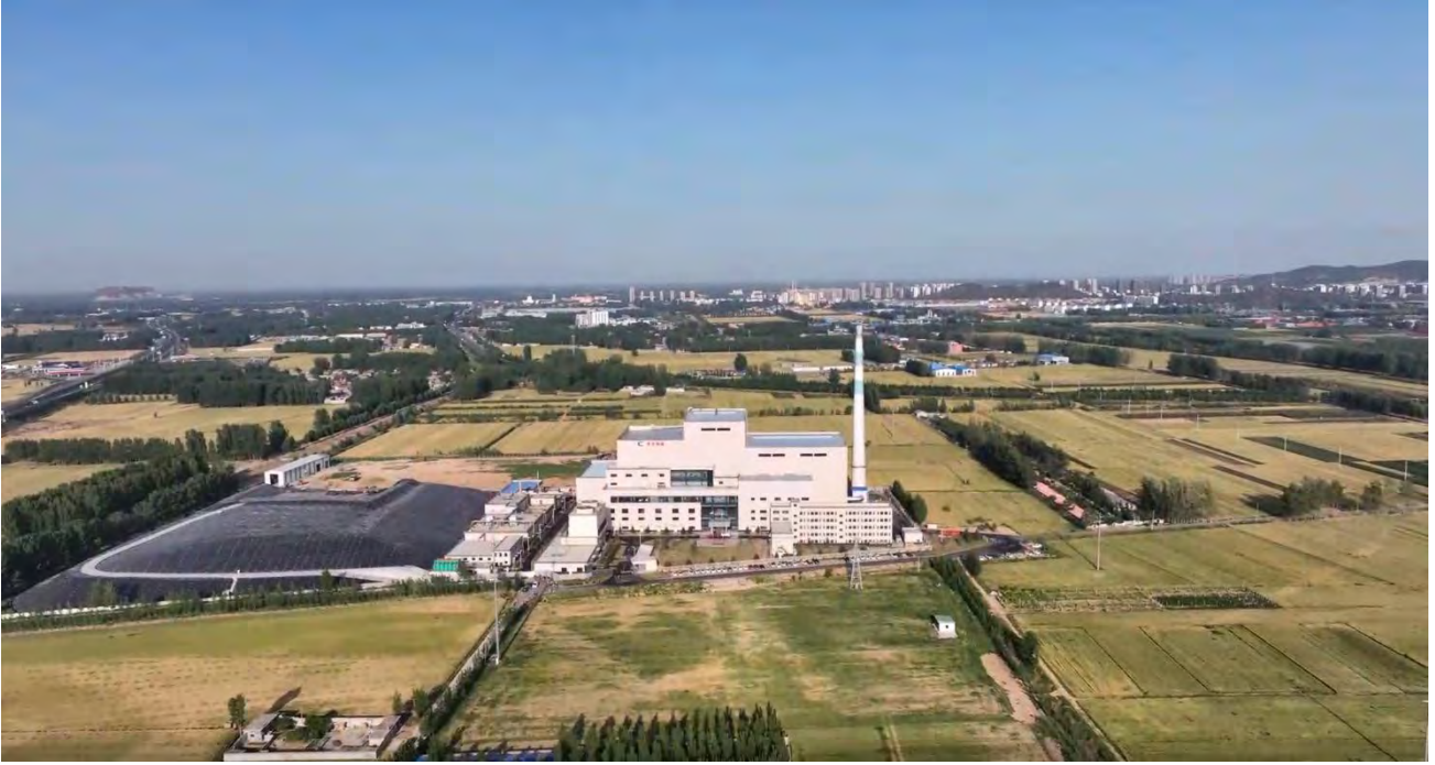
图 3-10 环保能源垃圾焚烧发电厂及垃圾填埋场
